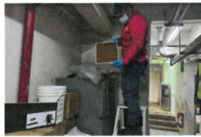
1140516交大二餐地下室046
