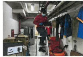
1140516交大二餐地下室047
