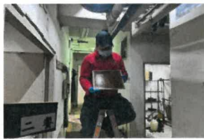
1140516交大二餐地下室044
