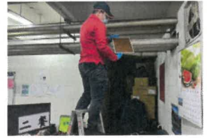
1140516交大二餐地下室042
