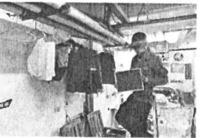
1130919交大二餐地下室006
