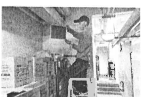
1130919交大二餐地下室005
