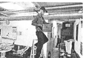
1130919交大二餐地下室007
