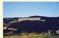
民國63年實驗大樓竣工，為陽明第一棟建築物
