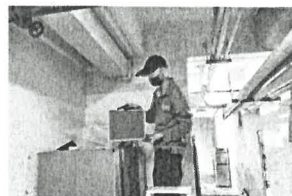
1130614交大二餐地下室014
