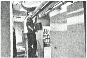
1130514交大二餐地下室008
