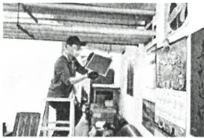
1130514交大二餐地下室005
