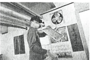
1130417交大二餐地下室010
