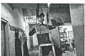
1130417交大二餐地下室013
